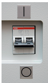
Рисунок 10. Автомат защиты (положение "Выключено")
