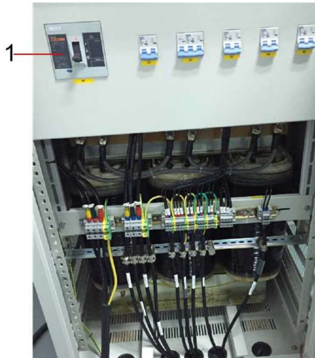
Рисунок 3-8 Внутренний вид ПДУ
