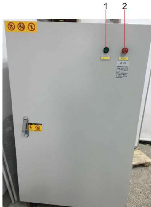
Рисунок 2-3 Кнопка аварийного отключения на БРП
